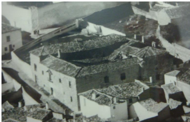
Vista aérea del hospital de San Andrés
