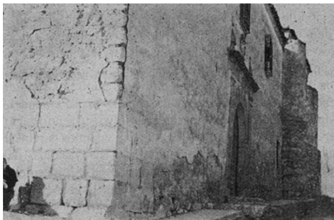
Hospital antes de su hundimiento en 1977
