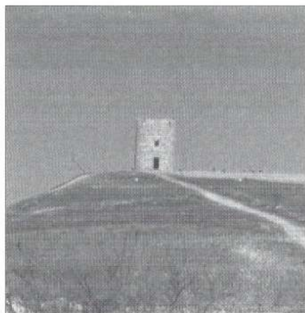
Estado actual del molino el puntal tras el incendio de agosto de 2003
