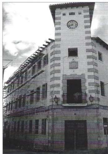
Andamios instalados en la fachada del Ayuntamiento
